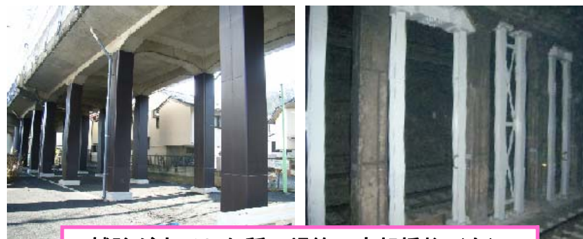
補強が完了した稲田堤第1高架橋柱（左） 新宿ずい道の中柱（右）
