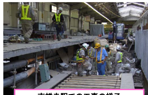
吉祥寺駅での工事の様子
