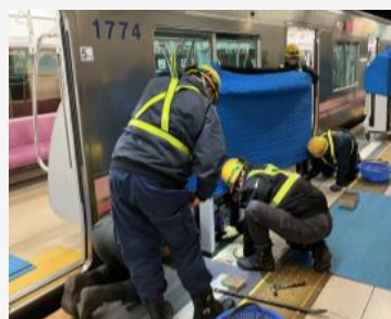
搬入から設置
