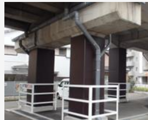
高架橋耐震補強
