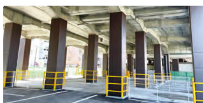
耐震補強を実施した高架橋柱
