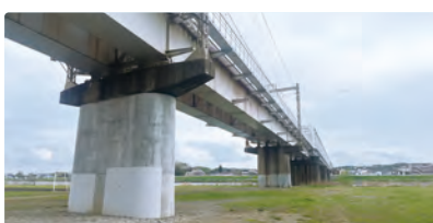
多摩川橋梁耐震補強
