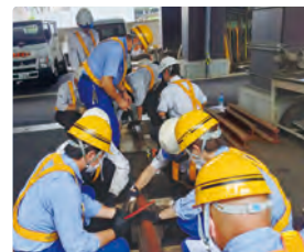
レールの応急復旧訓練
