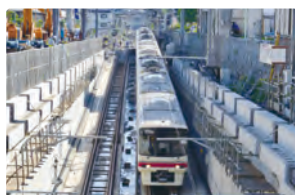
調布駅付近地下化切替工事
