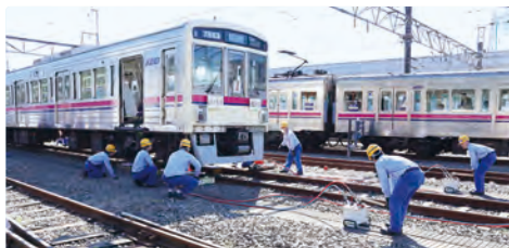
脱線車両の復旧
