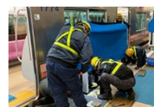
搬入から設置
