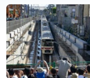
調布駅付近地下化切替工事
