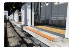
転落防止ゴムの設置 ホームかさ上げ
