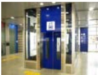
エレベーター
