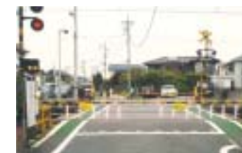
歩道部分のカラー舗装化
