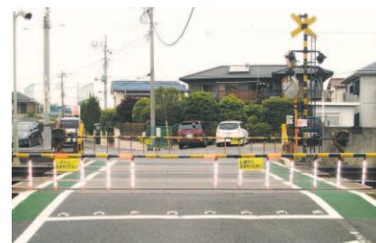
歩道部分カラー舗装化、くぐり抜け防止啓発テープ
