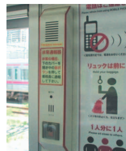
車内非常通報器 (通話可能なタイプ)
