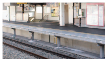
芦花公園駅ホーム下退避スペース
