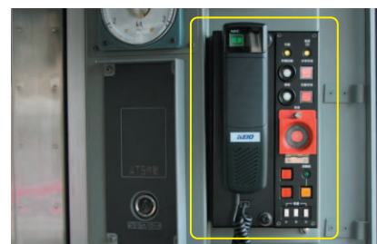
乗務員室の列車防護無線装置
