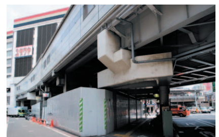
吉祥寺駅高架橋
