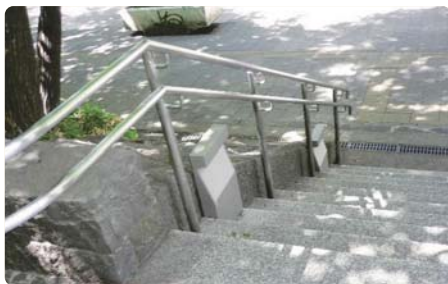
ホテルの外構階段に2段手すりと足元灯を設置
