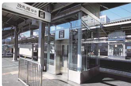
エレベーター出入口の転落防止柵
