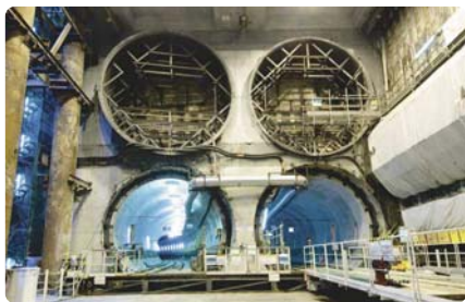
調布駅 西側立坑
