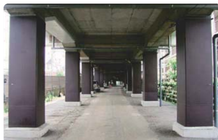
銅板巻きによる高架橋柱耐震補強
