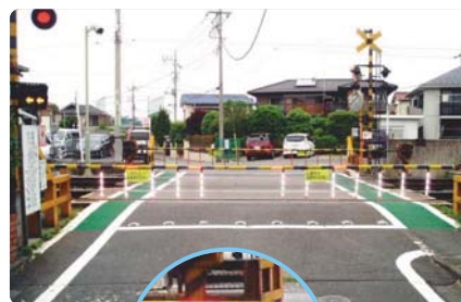
踏切歩道部のカラー舗装化
