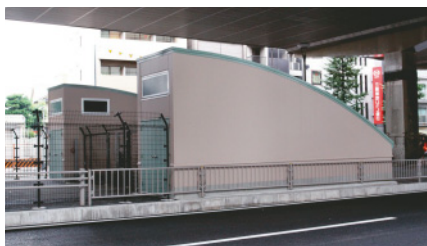
幡ヶ谷駅に新設した避難通路(上)と地上出口(下)
