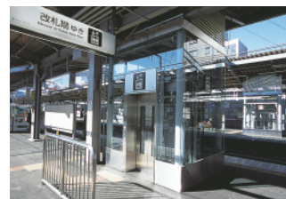
エレベーター出入口の転落防止柵
