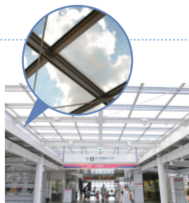
自然光を採り込む透過式の太陽光パネル
