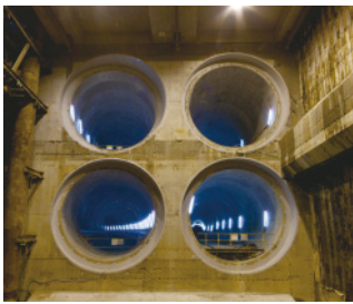
調布駅 西側立坑
