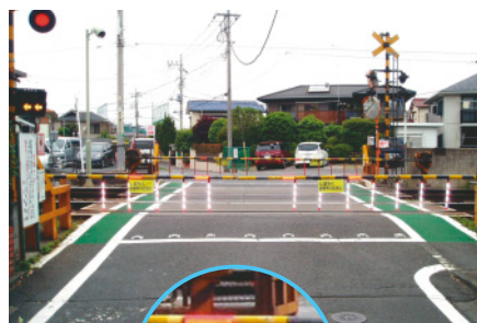
踏切歩道部のカラー舗装化
