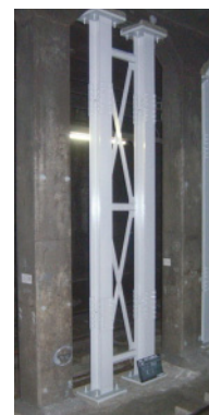
鋼柱増設によるずい道耐震補強
