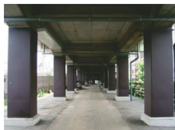
鋼板巻きによる高架橋柱耐震補強
