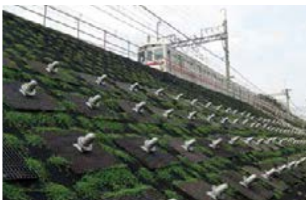
盛土区間の耐震補強
