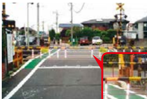
踏切歩道部のカラー舗装化
