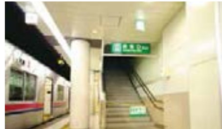
新たに設置した避難通路 (幡ヶ谷駅)
