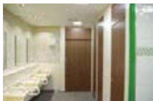
改修したお客様用トイレ
