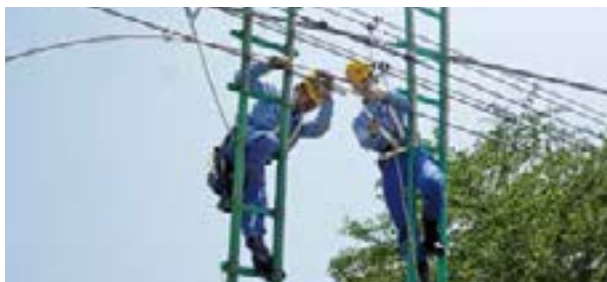
架線の断線復旧訓練
