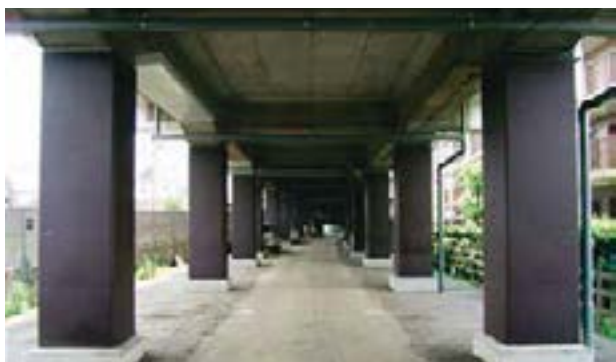
鋼板巻きによる高架橋柱耐震補強
