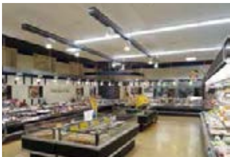
LED照明を導入した京王ストア店舗
