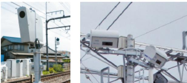
(光軸式) 踏切障害物検知装置 (3次元レーザー式)
