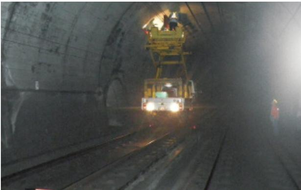
高所作業車によるトンネル天井部分の点検
