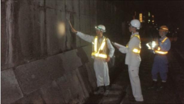
トンネルの打音検査
