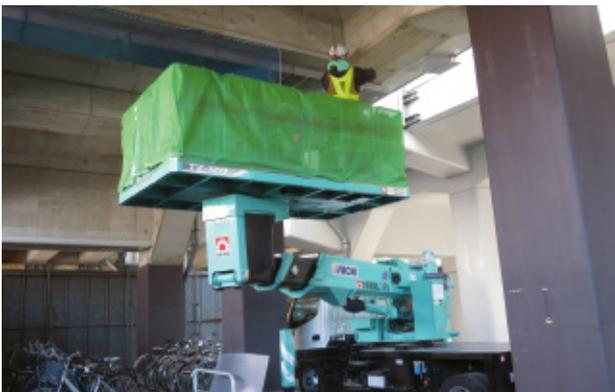
高所作業車による高架橋の点検
