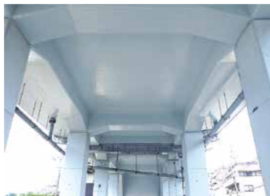
剥離対策を施した高架橋
