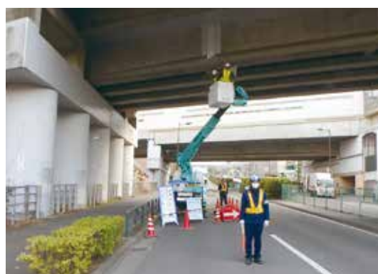
高架橋の点検
