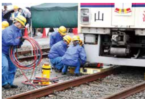
脱線車両の復旧
