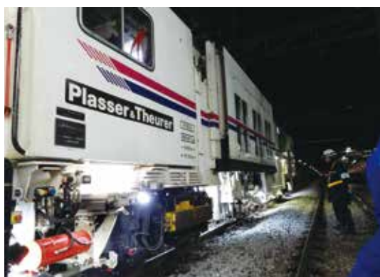
マルチプルタイタンパーによる道床つき固め
