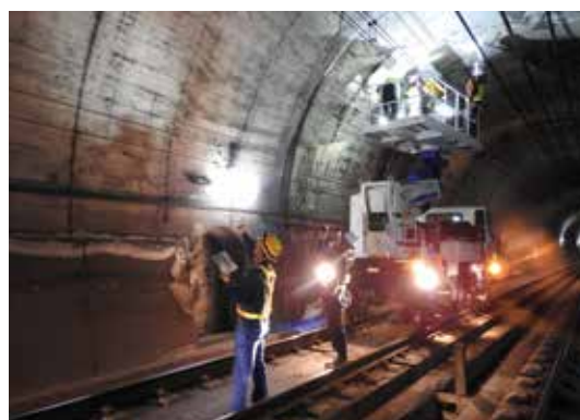
トンネル天井部の点検
