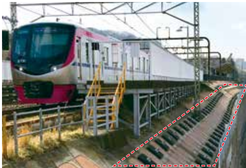
盛土区間の耐震補強
