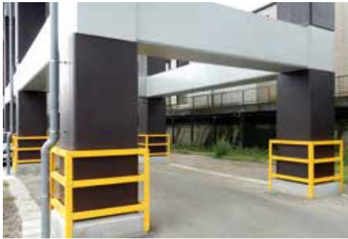
高架橋柱の耐震補強
