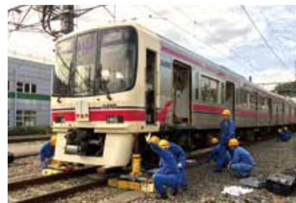
車両の脱線復旧訓練
