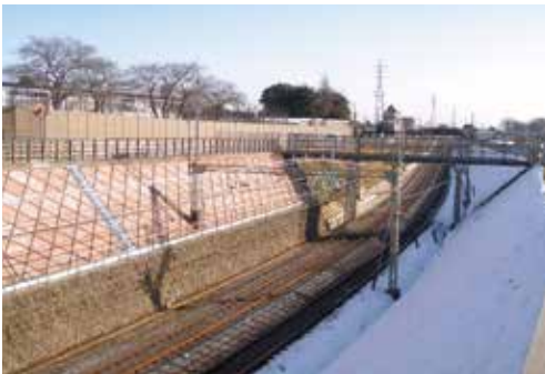
補強工事が完了した線路脇斜面
