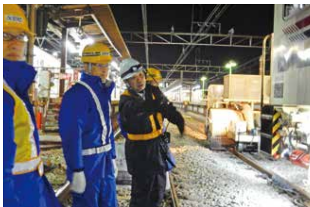
社長による夜間作業(道床つき固め)の視察
