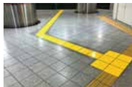
新線新宿駅 誘導ブロック
