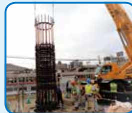
基礎杭施工状況
