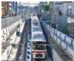
調布駅付近地下化切り替え工事
