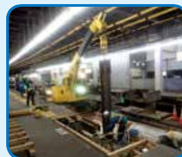
土留杭施工状況
