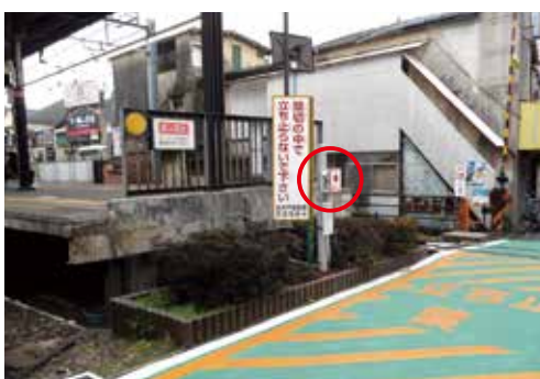
踏切内の踏切支障報知装置 (非常ボタン)
