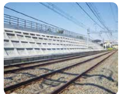
法面改修(北野駅～京王片倉駅間)
