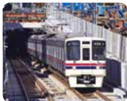
立体交差化した国領駅付近
