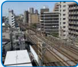
仮線工事準備(引上線一部撤去)
