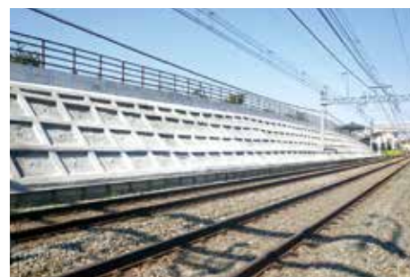
法面改修 (北野駅～京王片倉駅間)
