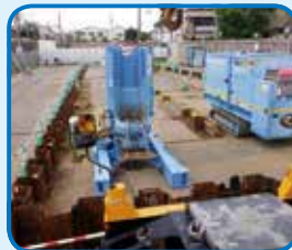
土留杭設置完了状況
