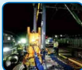
土留杭施工状況
