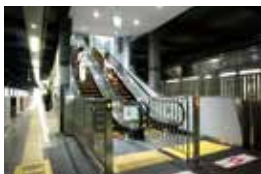
仙川駅 エスカレーター
