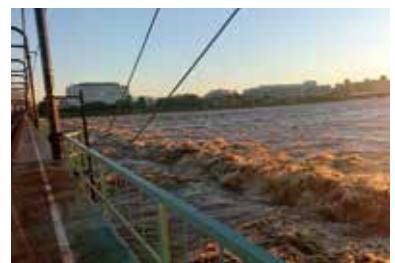
台風通過後の京王線多摩川鉄橋
