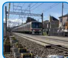
土留杭設置完了状況
