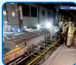
下りホーム一時撤去状況
