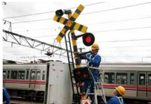
踏切設備の復旧
