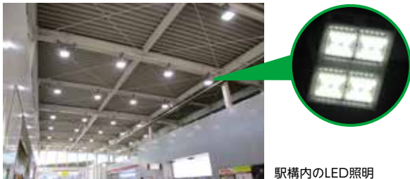
駅構内のLED照明
