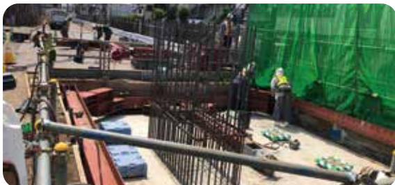
高架橋構築箇所
