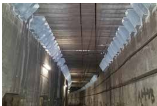
耐震補強を実施したトンネル
