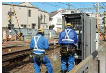
踏切保安設備の点検
