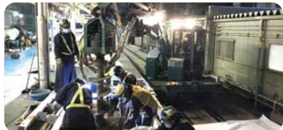
下北沢駅ホーム補強工事
