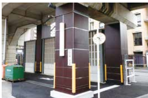
耐震補強を実施した高架橋柱
