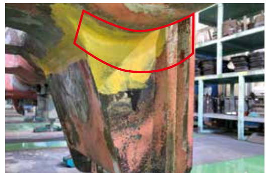
恒久対策実施箇所
