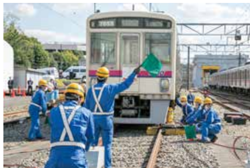
脱線車両の復旧
