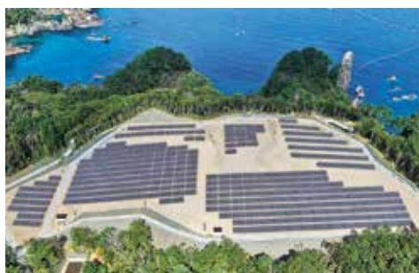
岩手県宮古市の太陽光発電システム
