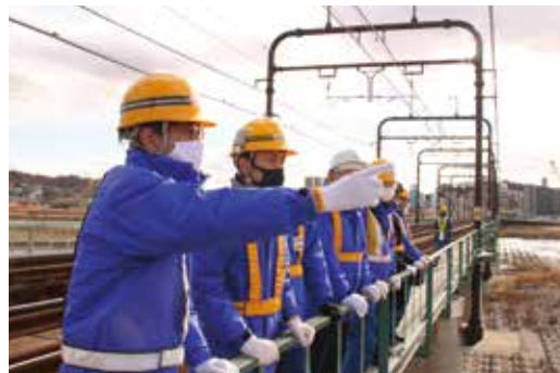
社長による橋梁工事の視察
