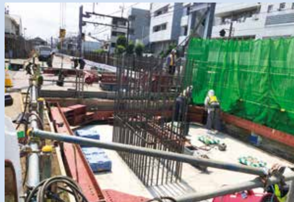
高架橋構築箇所
