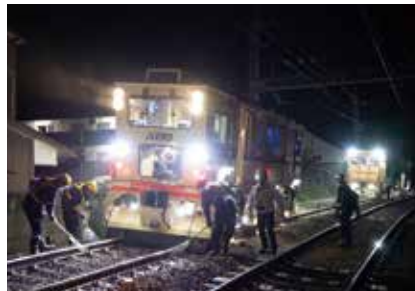
道床のつき固め
