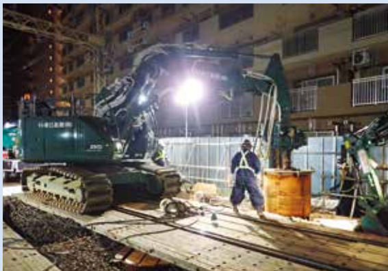
仮高架橋(工事桁)支持杭設置箇所
