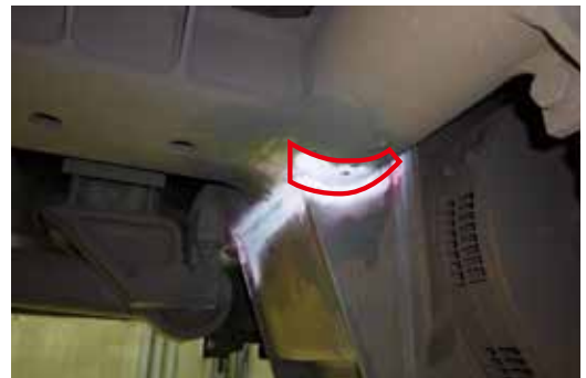
き裂発生箇所
