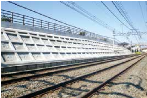
法面改修(北野駅～京王片倉駅間)
