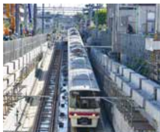
調布駅付近地下化切り替え工事
