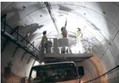
トンネル天井部の点検
