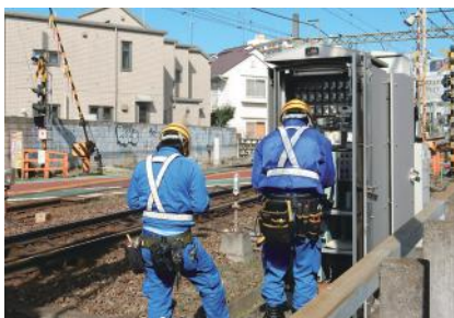
踏切保安設備の点検
