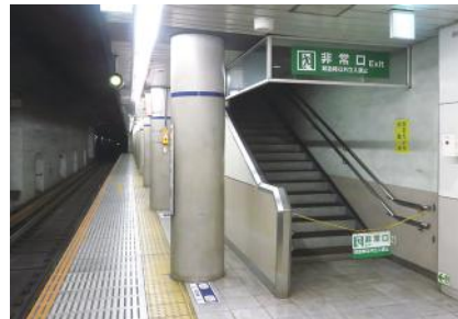
幅ヶ谷駅の避難通路
