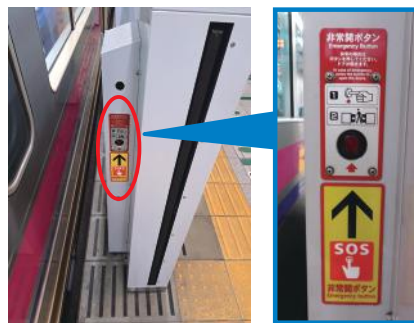
ホームドア非常開ボタン
