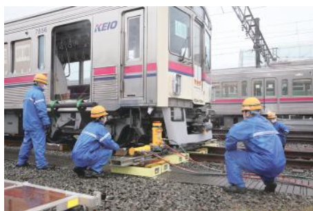
脱線車両の復旧
