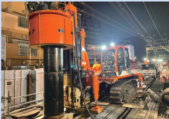
仮高架橋支持杭設置箇所(笹塚駅側取付部)
