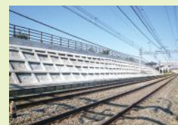
① 激甚化する台風など異常気象に対して法面改修などを実施
