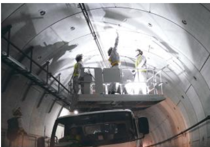
トンネル天井部の点検
