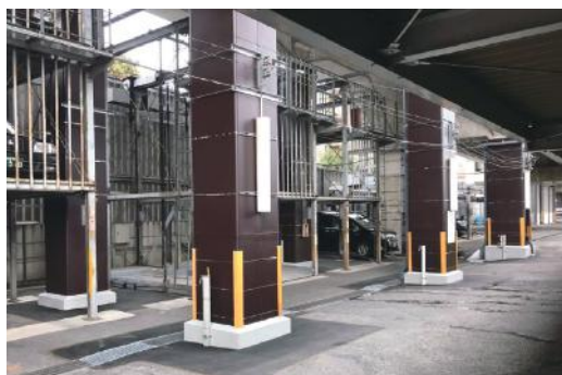
耐震補強を実施した高架橋柱
