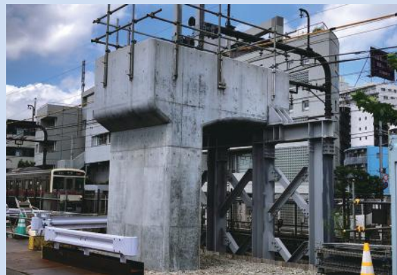
高架橋構築箇所(明大前駅付近)
