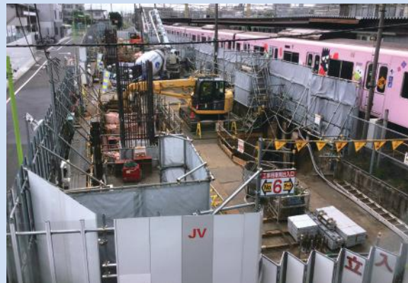
高架橋構築箇所(桜上水駅付近)
