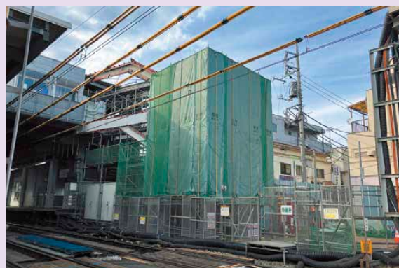
橋上駅舎解体状況(芦花公園駅)
