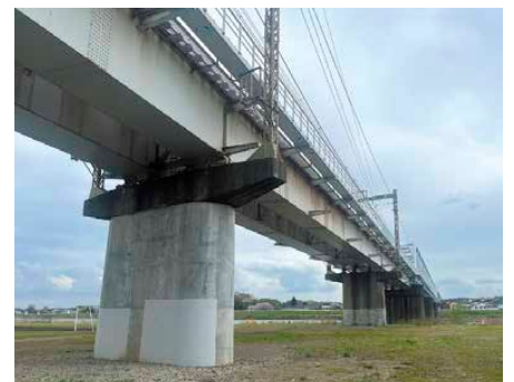
多摩川橋梁耐震補強
