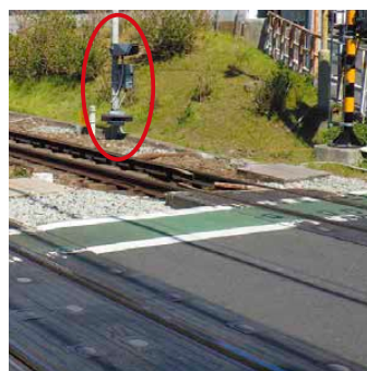
高機能型 (エリア検知式) 踏切障害物検知装置
