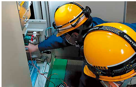
変電所の点検
