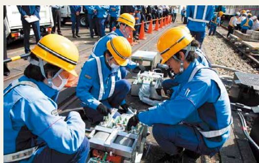
通信設備の復旧
