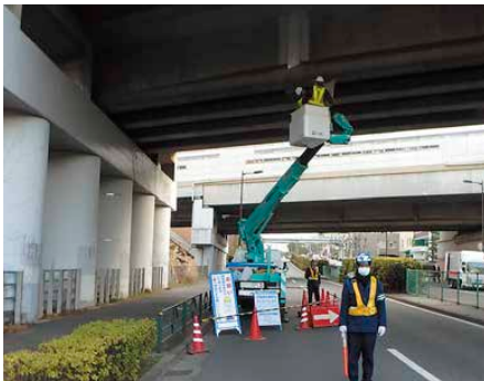
高架橋の点検
