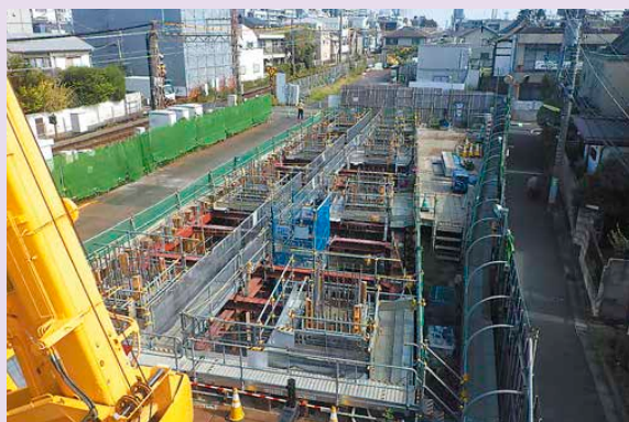
高架橋構築状況(明大前駅付近)
