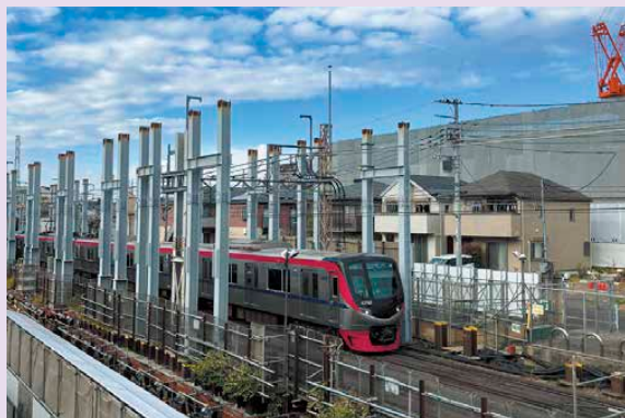
仮高架橋設置状況(仙川駅側取付部)
