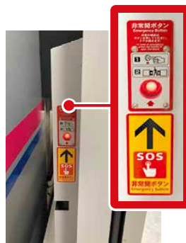
ホームドア非常開ボタン
