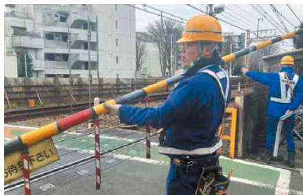
踏切保安設備の点検
