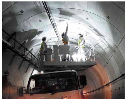
トンネル天井部の点検
