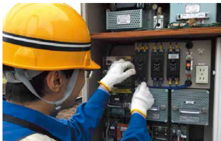
踏切保安設備の点検
