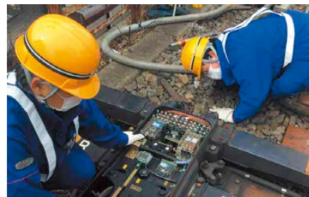
転てつ器の点検
