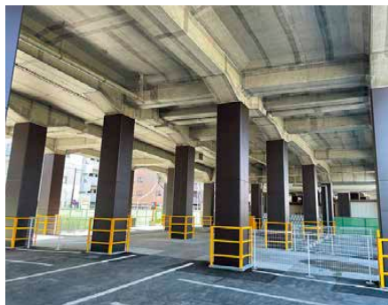
耐震補強を実施した高架橋柱
