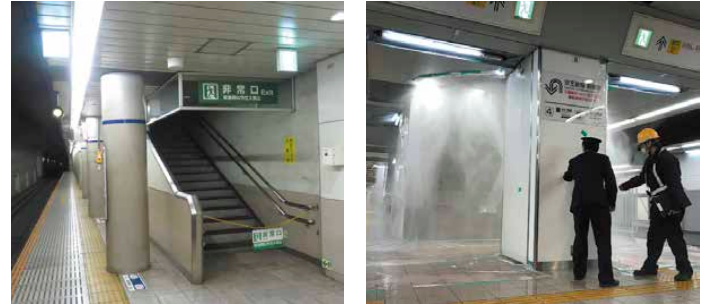
幡ヶ谷駅の非常口階段
