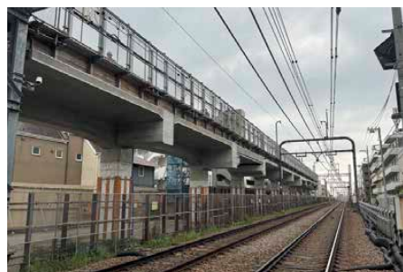
連続立体交差事業
