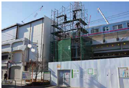
京王多摩川駅改良工事
