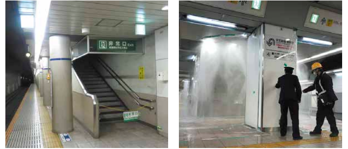
幡ヶ谷駅の非常口階段
