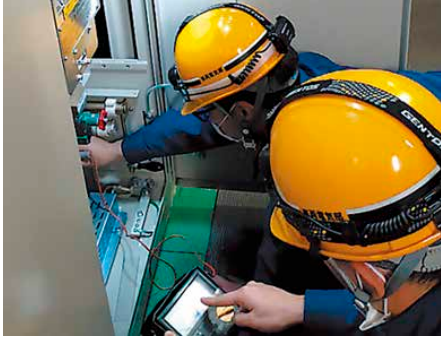
変電所の点検
