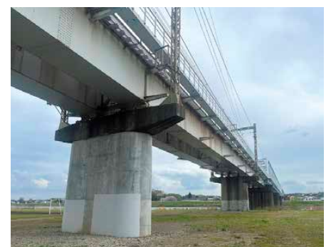
多摩川橋梁耐震補強
