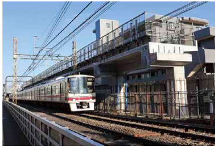
連続立体交差事業
