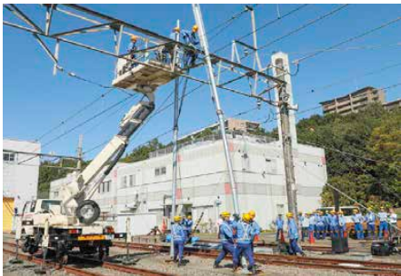
鋼管連結式台棒の設置訓練
