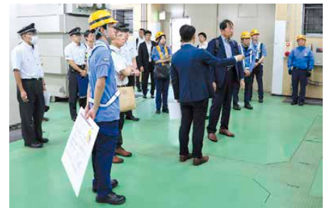
変電所の視察
