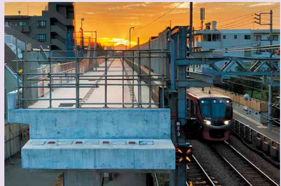
高架橋構築状況(千歳烏山駅付近)
