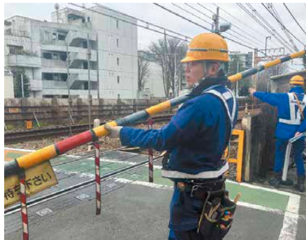
踏切保安設備の点検
