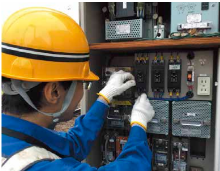
踏切保安設備の点検
