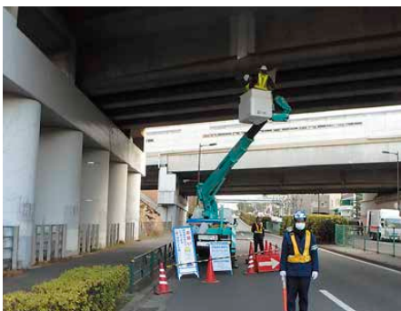
高架橋の点検
