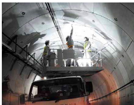
トンネル天井部の点検
