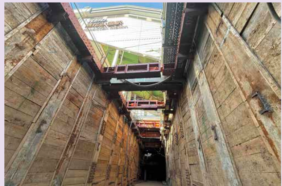
仮旅客通路整備状況(芦花公園駅)
