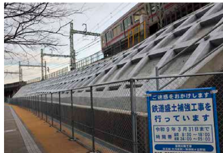
法面改修工事
