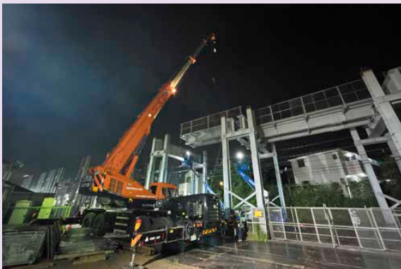
仮高架橋構築状況(仙川駅側取付部)
