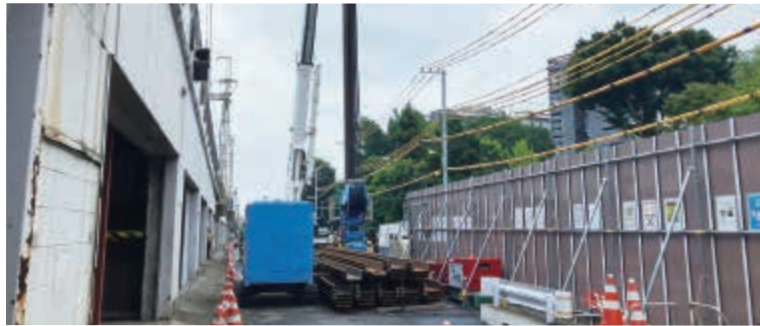
土留杭設置状況(上北沢駅～八幡山駅間)
