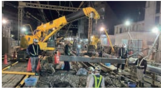
仮高架橋設置状況(環七通り～代田橋駅間)
