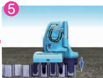
掴んでいる杭を完全に押し込んでいく
