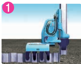
杭を鋼矢板圧入機にセットする
