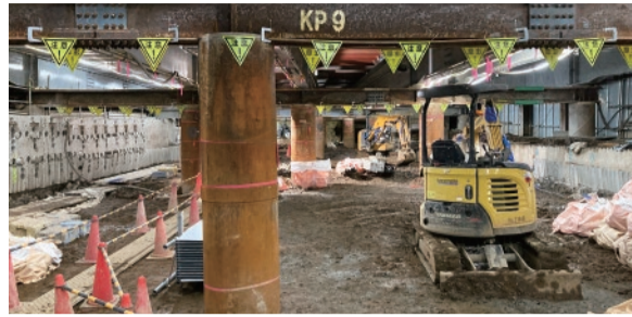
盛土撤去状況(笹塚駅～代田橋駅間)
