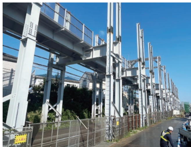
仮高架橋設置状況(千歳烏山駅～仙川駅間)
