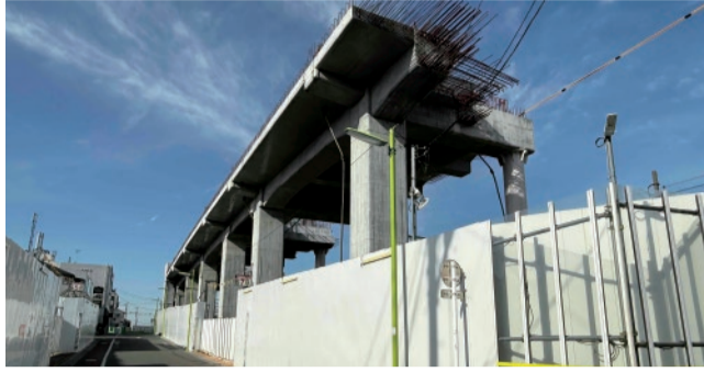
高架橋構築状況 (桜上水駅付近)
