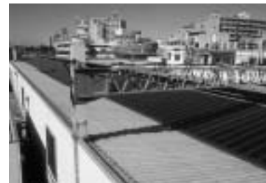
太陽光発電システム
