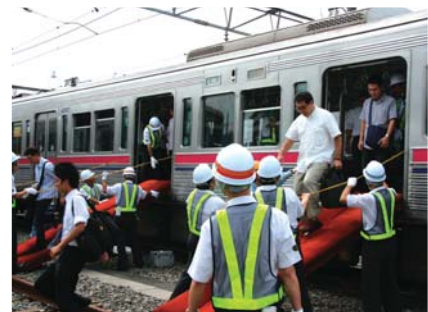
事故復旧訓練
