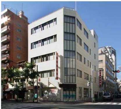
施工例：昭和信用金庫京橋支店 新築工事 (京王建設)
