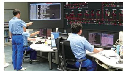
列車運転用電力と駅設備や信号保安設備などに用いる付帯用電力を供給する、20カ所の変電所の運転状況や送電状況を、集中監視制御システムにより24時間体制で監視しています。
