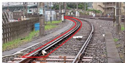
国からの通達では、半径200m以下の曲線に脱線防止ガードを設置することが定められていますが、当社では、その基準を上回る半径300m以下の曲線に設置しています。また、ポイント(分岐器)や踏切道にも設置しています。
