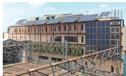
2013年に、高幡不動駅の敷地内に、太陽光発電システムなど13種類の環境に配慮した設備を組み合わせ活用した、鉄道現業の事務所(高幡不動乗務区・施設管理所)を開設しました。従来の施設と比べて、約30%の省電力と節水を実現しています。
