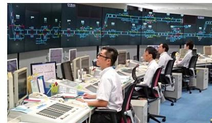
(列車運行管理システム)により、列車の進路設定、出発指示合図などを自動制御しています。事故発生時には、列車の位置や遅れなどを総合的に判断し、運行ダイヤの整理・復旧を図るとともに、駅の「お客さま案内ディスプレイ」や「車内案内表示器」などを通じて運輸指令所から一括してお客様に最新情報をご案内しています。
