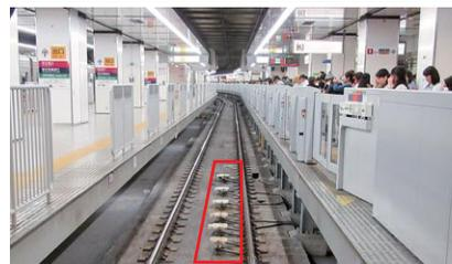
過走余裕距離が特に短い終端駅などに設置しています。複数の地上子がそれぞれ列車の速度を照査し、制限速度以上で列車が通過したときは非常ブレーキを作動させて列車を停止させます。
