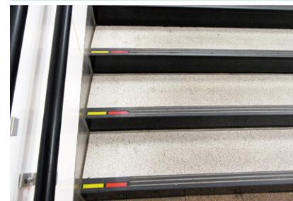
階段の段差を視覚的に認識しやすいよう、全駅の階段踏面の端部に明度差を付けています。
