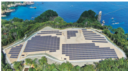
宮古市の発電設備
