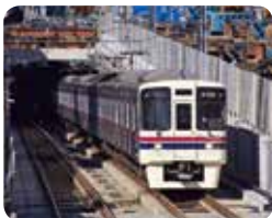
立体交差化した国領駅付近
