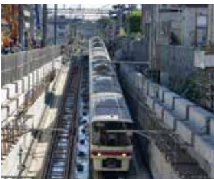
調布駅付近地下化切り替え工事
