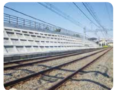
法面改修(北野駅～京王片倉駅間)
