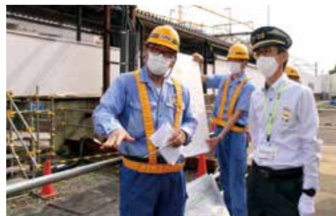
社長による連続立体交差工事の視察
