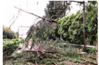
駒場東大前駅～池ノ上駅間での倒木
