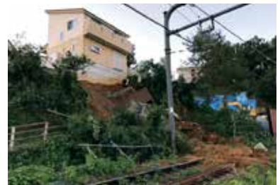
高幡不動駅～多摩動物公園駅間での土砂崩壊
