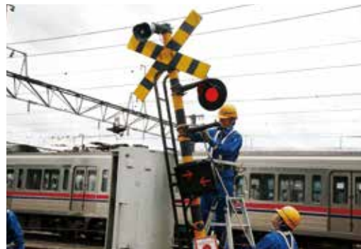
踏切設備の復旧
