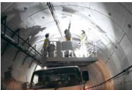
トンネル天井部の点検
