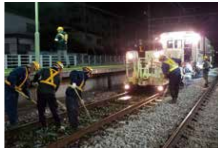
道床のつき固め
