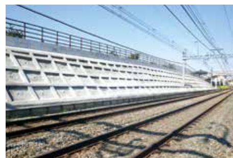
法面改修 (北野駅～京王片倉駅間)
