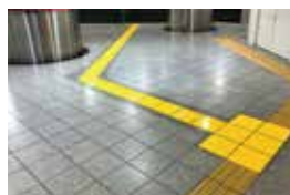
新線新宿駅 誘導ブロック
