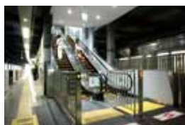
仙川駅 エスカレーター
