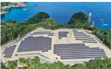
岩手県宮古市の太陽光発電システム
