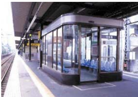
上北沢駅に設置したホーム待合室
