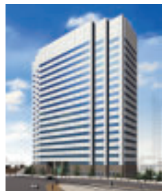
JR品川駅東口B-4地区 賃貸オフィスビル完成予想図
