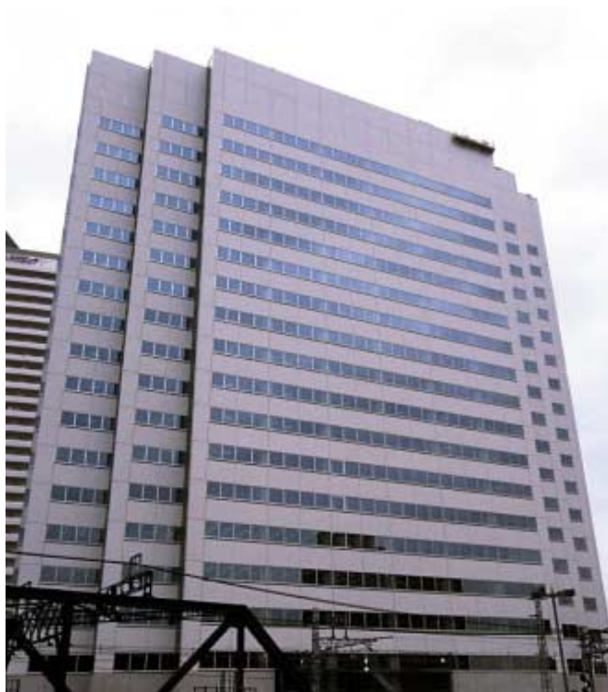
京王品川ビル(建設中)
