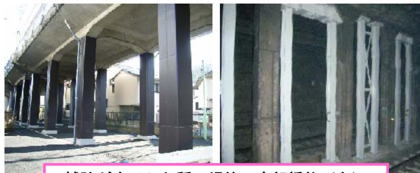
補強が完了した稲田堤第1高架橋柱（左）
