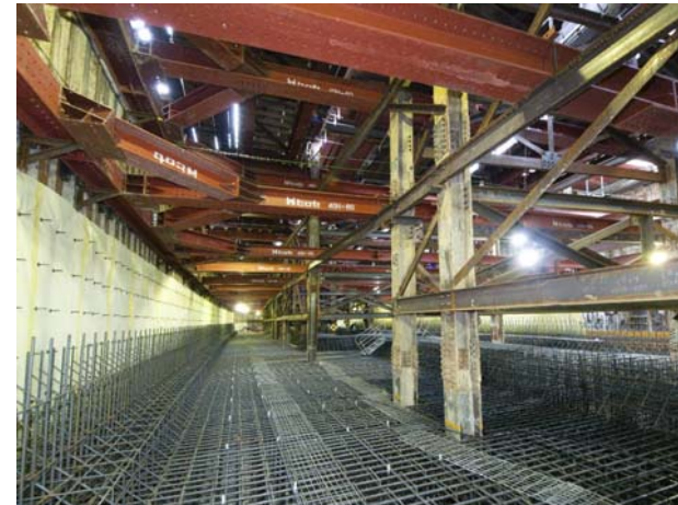
《調布駅付近連続立体交差事業》 国領駅線路下の状況
