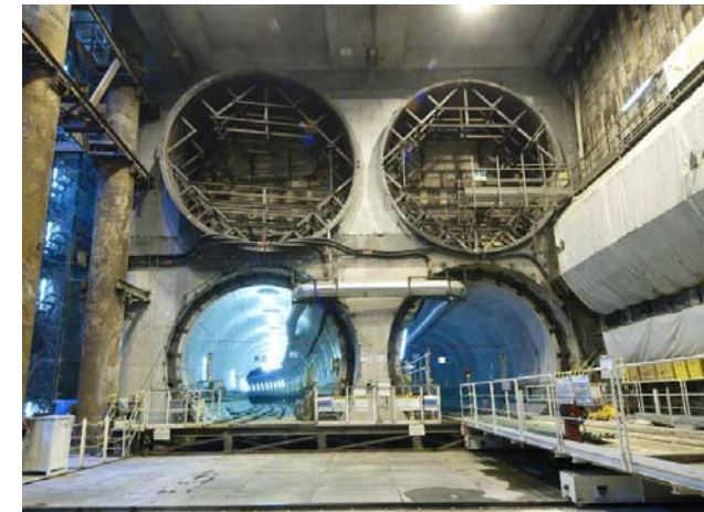
調布駅西側立坑の様子 (調布駅～西調布駅間、調布駅～京王多摩川駅間の 上り線トンネルが貫通)
