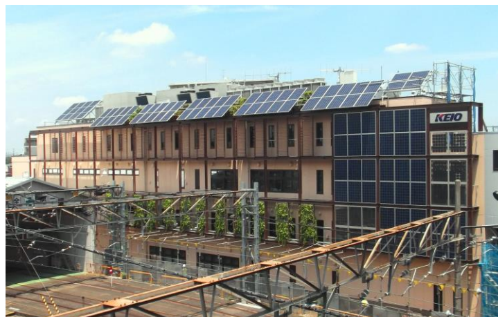
高幡不動乗務区・施設管理所 外観
