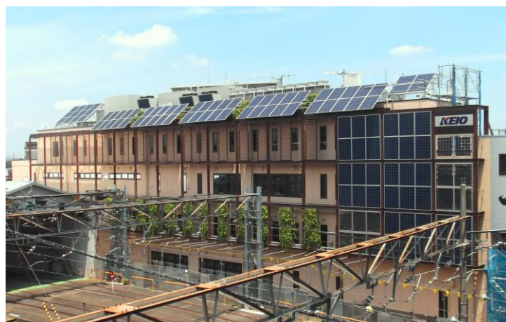
高幡不動現業事務所 外観
