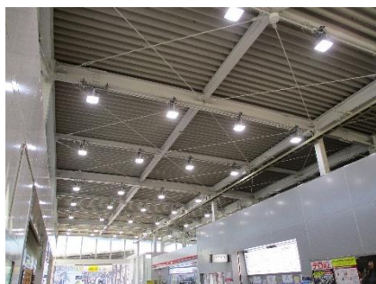
《照明設備のLED化（稲城駅）》
