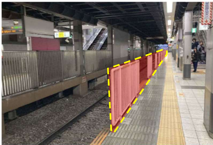
※撤去する固定柵
