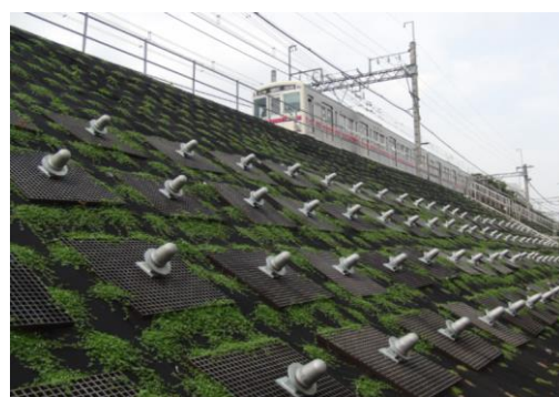
《補強後の盛土区間》
