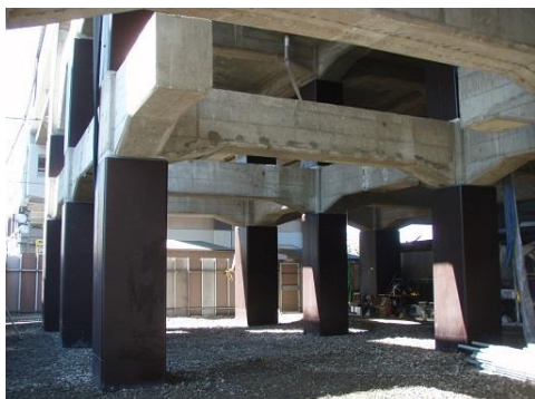
《補強後の高架橋》
