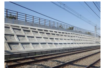
《高尾線 線路脇斜面の防護》
