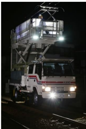
＜電力関係の保守作業の様子＞
