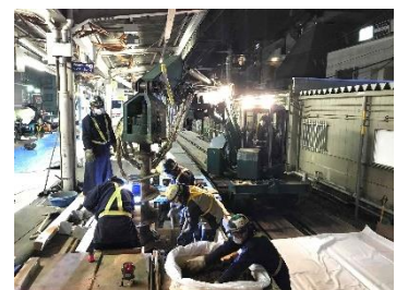
《下北沢駅ホーム補強工事》
