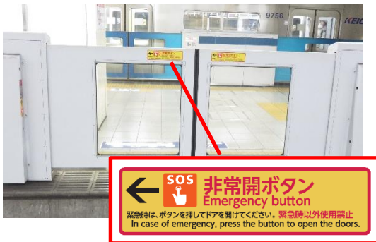
《ホームドア非常開ボタン》
